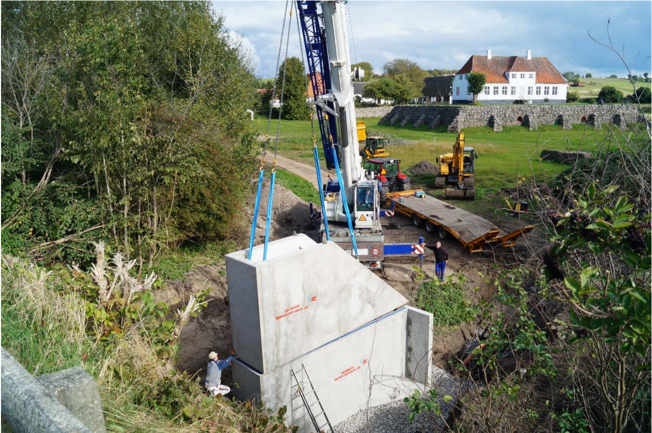
Figur 3: Det nye stemmeværk monteres
